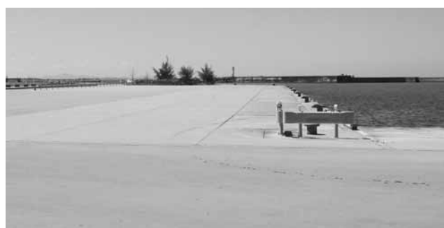
ー7.5m 岸壁の状況
