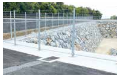
浸透池と水兼農道
