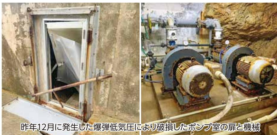
昨年12月に発生した爆弾低気圧により破損したポンプ室の扉と機械
