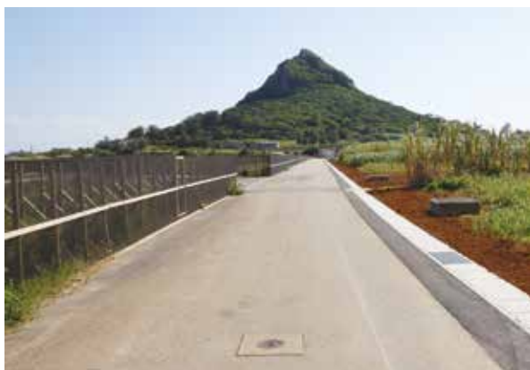
トレンチ工法を使用した植栽帯
