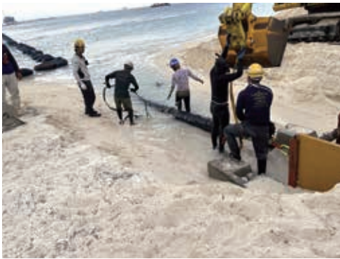
50年間に一度の海底送水管の布設工事
