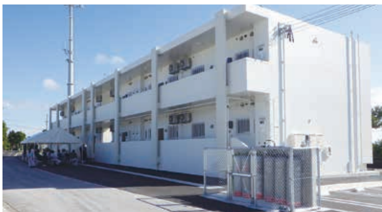
令和4年に供用開始した伊江中学校教員宿舎
