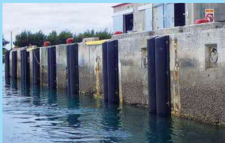
具志漁港機能保全工事
