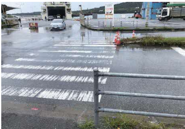
本部港臨港道路 (整備前)
