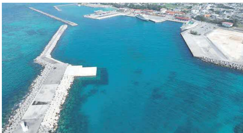
改修工事後の伊江港湾
